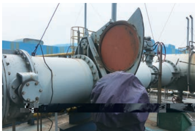
煤氣管線直徑在1.8米以下的全部改造成電動盲板閥
